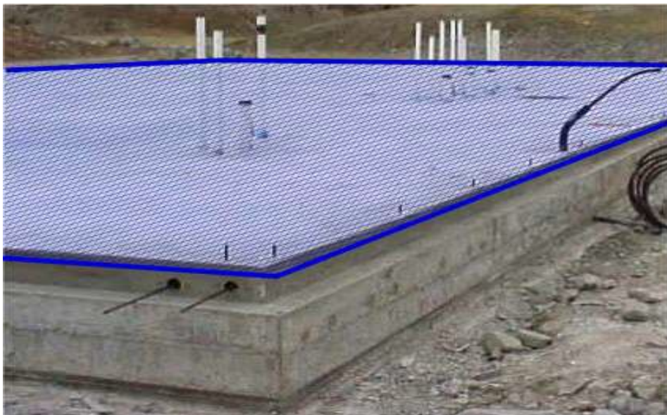
Figur 29 - Exempel på planläge husgrund för en bottenyta (Bilder: Referens [11] )
