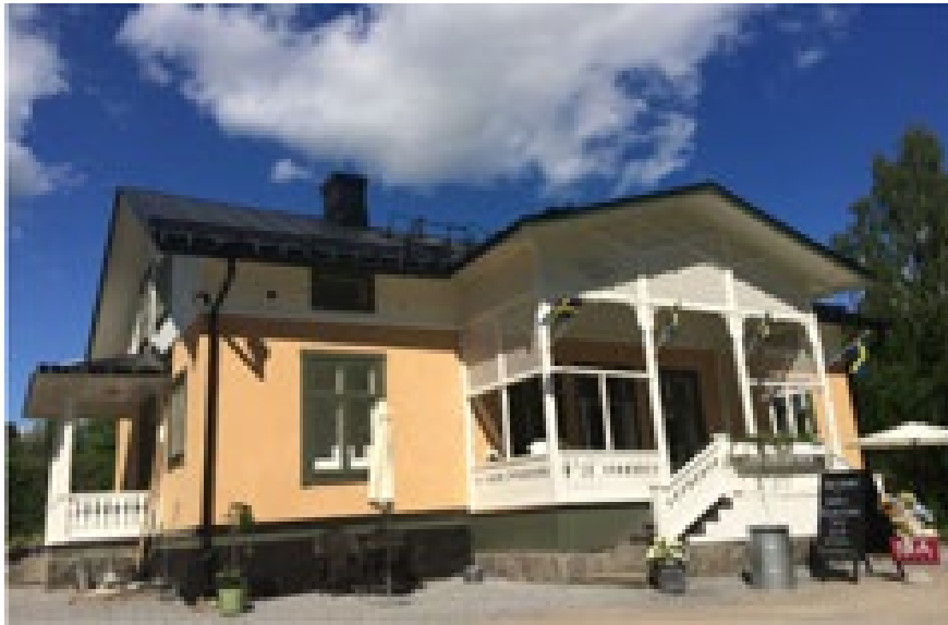
Figur 110 - Kaanans trädgårdscafé inmätt enligt olika NS LOD. Byggnaden har mindre utbyggnader i annan takhöjd och taköverhäng. För NS LOD 2.1a-b är den indelad i byggnadsdelar med indelningsgrund {höjd}. För NS LOD 2.2a är taket indelad i {tak utan överhäng} och {överhäng}. Observera att den mindre byggnadsdelen på vänstra gaveln saknas i NS LOD 2.2a eftersom den inte finns med i den geodetisk mätningen av bottenytan, se t ex NS LOD 0c.
