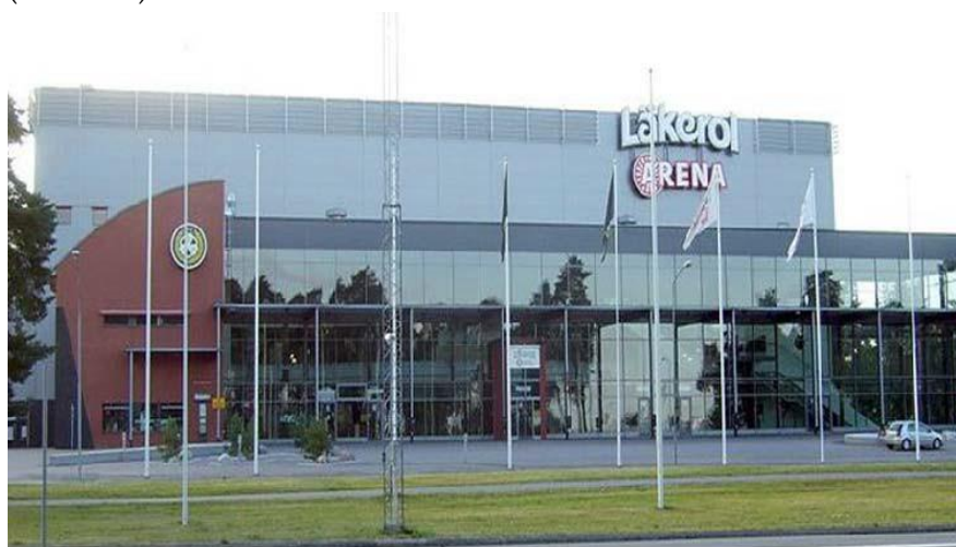
Gavlerinken 1967 > Läkerol Arena 2006 > Gavlerinken Arena 2014.
