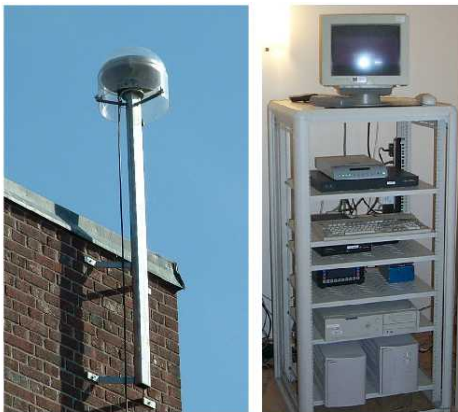
Figur 5: Ett exempel på hur antennstativ och utrustning kan se ut på en projektstation
