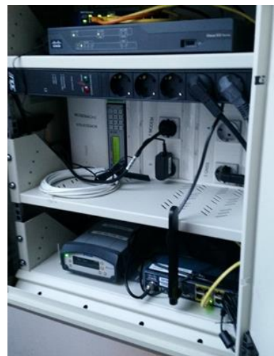
Figur 4 SWEPOS-stationen Mosebacke, en klass B-stationen vid Södra teatern på Södermalm i Stockholm. Till vänster antennen monterad på taket och till höger dataskåpet med tillhörande utrustning. Foto: SWEPOS Lantmäteriet.
