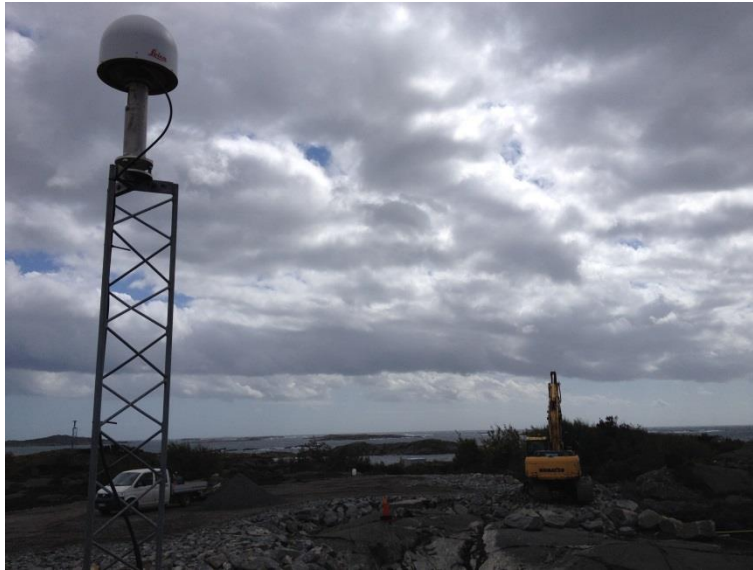
Bild på OTT4-antennen mot söder med vägarbetet och OTT6-masten i bakgrunden.
