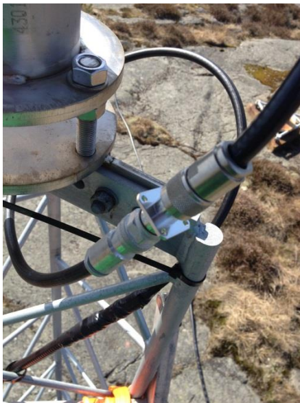
Infästningen av den extra antennsladden (vänster) och antennen med OSOS-radom och eccosorbkiva (höger).
