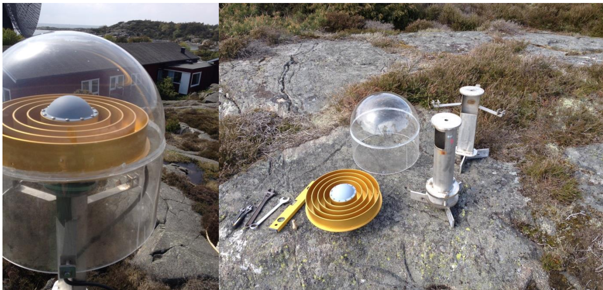
Den befintliga antennen med OSOD-radom tas ned (vänster). Därefter byts den rektangulära antennfoten, ses i bakgrunden, ut mot den tidigare använda cirkulära antennfoten, ses i förgrunden, (höger).
