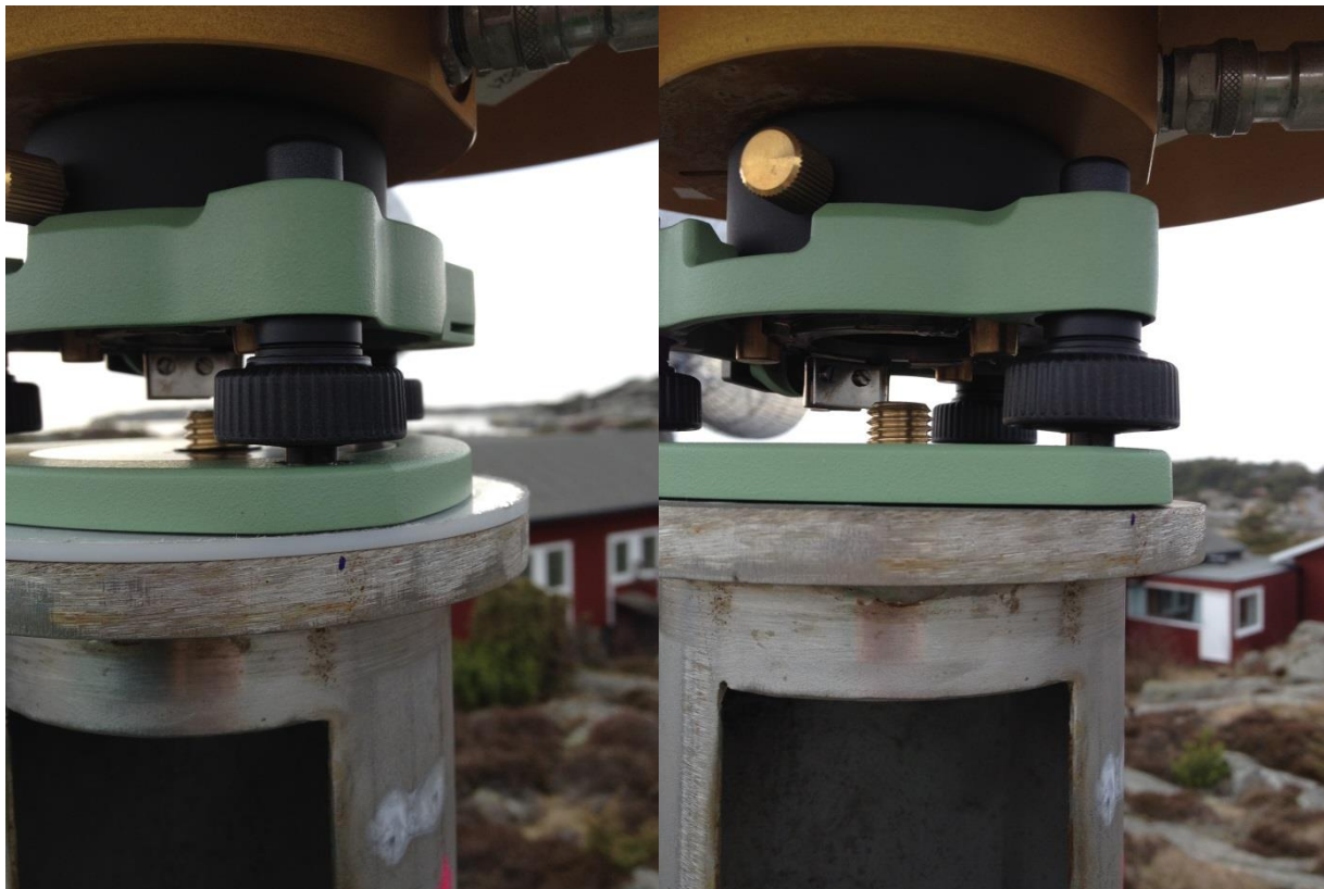
Före borttagandet av det isolerande skiktet (vänster) och efter borttagandet (höger).
