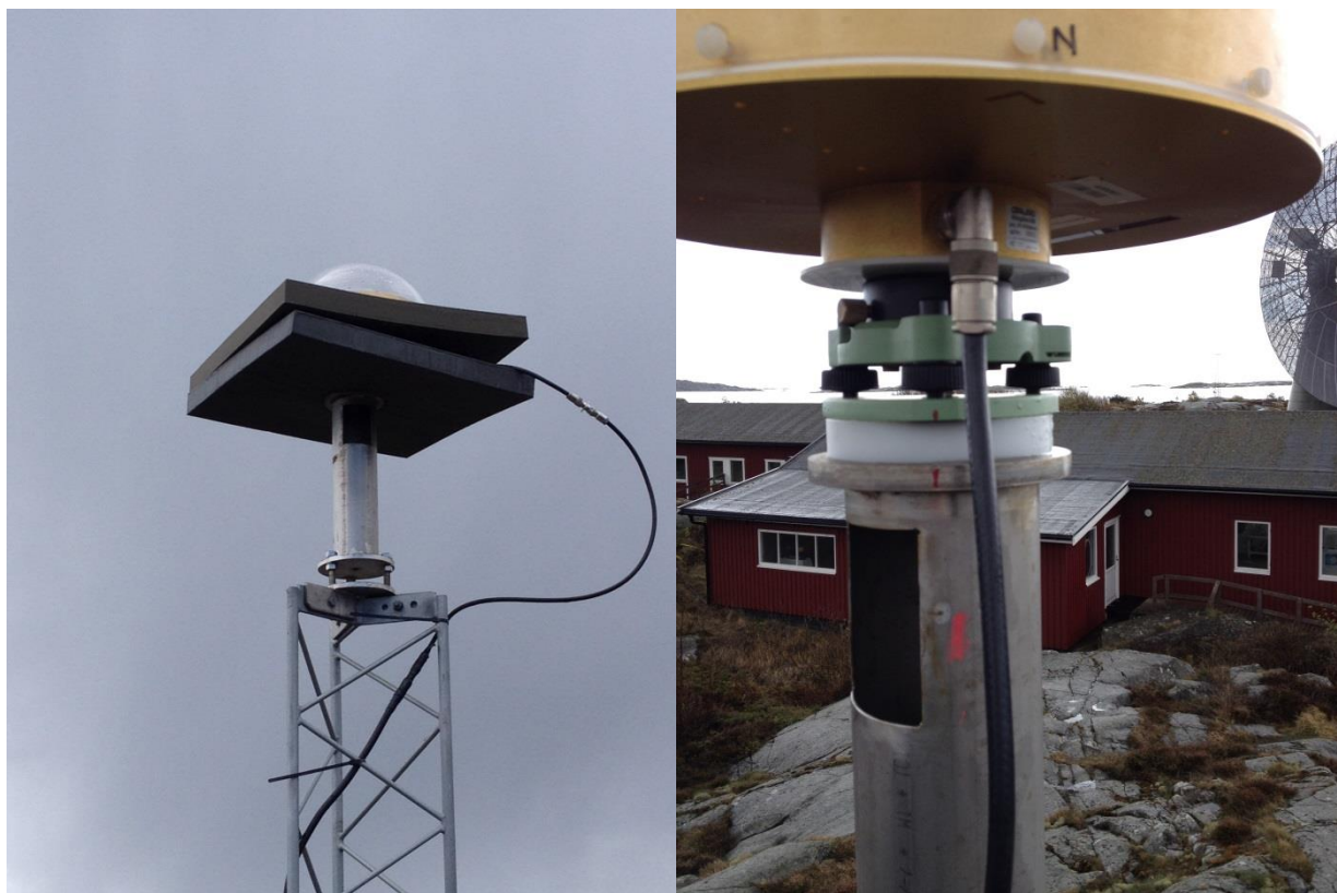
OTT2-masten med dubbla eccosorbskivor innan ändringen (vänster) och toppen av mastfoten för OTT2-masten efter ändringen (höger) då eccosorbskivorna har tagits bort och endast isolerande skikt och trefot är kvar.
