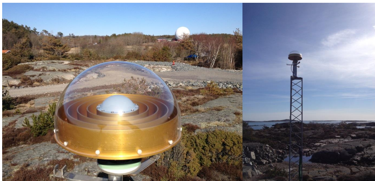
OTT4 med antenn och OSOS-radom installerad på en antennfot med tre armar fotat åt öster (vänster) och åt söder (höger).
